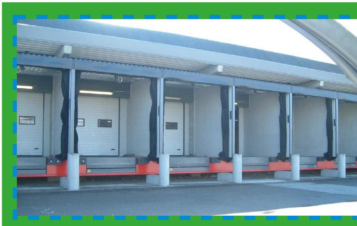
Se recomienda la combinación con semáforos indicadores de forma que se realice la maniobra de acercamiento cuando el abrigo esté deshinchado (semáforo verde) y no se realice la maniobra de salida hasta que el semáforo se haya vuelto a encender en verde indicando que el abrigo ha vuelto a deshincharse.
